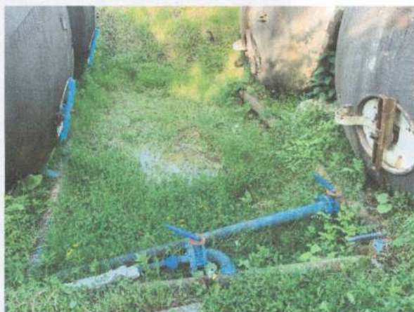
Fotografii 5 – 6 Rezervoarele de înmagazinare a apei de la Zona de Captare „Duruitoarea” ( W=4\times 50\text{m}^3 )
