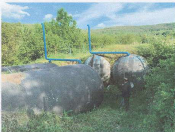
Fotografii 5 – 6 Rezervoarele de înmagazinare a apei de la Zona de Captare „Duruitoarea” ( W=4\times 50\text{m}^3 )
